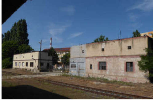
Irodaépületek a harmincas évekből, a vasúti és a hajózási adminisztráció számára
